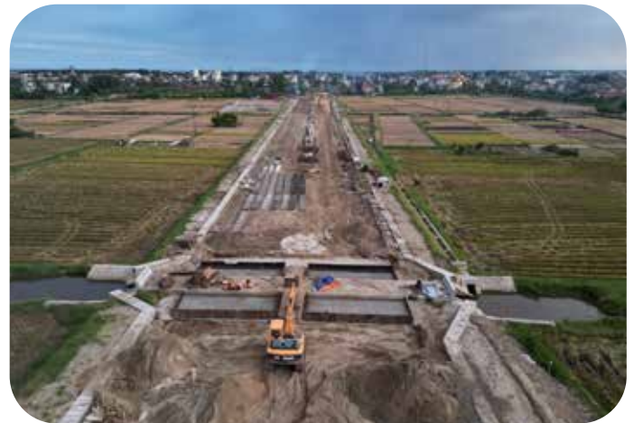
DA Hạ Tầng Đường Số 2 Thái Thụy
