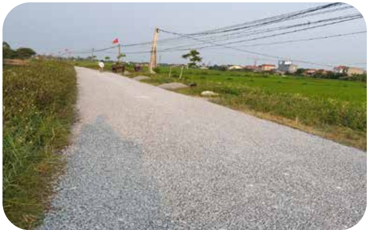
Cải tạo nâng cấp đường DH90 tại xã Thụy Ninh, Thái Thụy, Thái Bình
